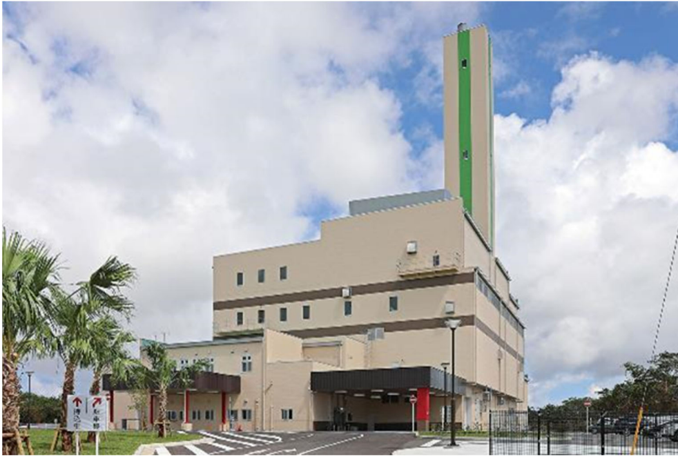
図3.3-1 金武地区清掃センターの外観
